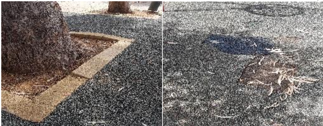
גן אז"ר - בליטה גדולה במשטח הגומי כתוצאה משורשי עץ וגומי קרוע
